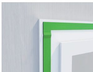
Respecter une surlongueur de 1 cm par jonction
